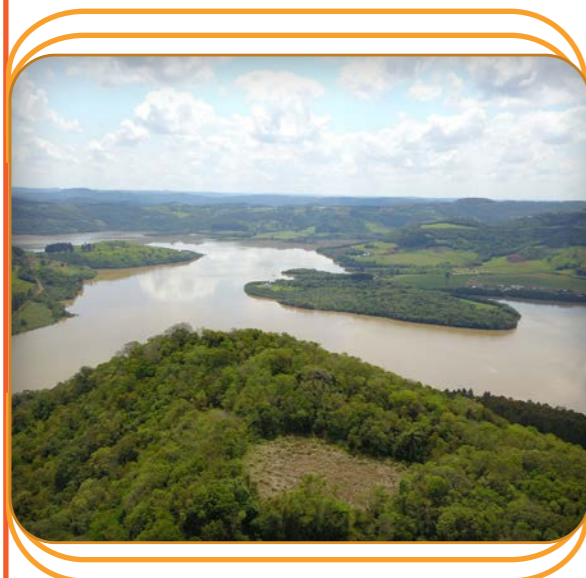
Reservatório da UHE Campos Novos no rio Pelotas.
