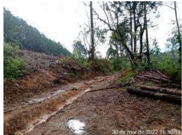
Foto 12 - Obstáculos nas estradas e domicílios fechados devido ao vendaval ocorrido na grande Curitiba.
