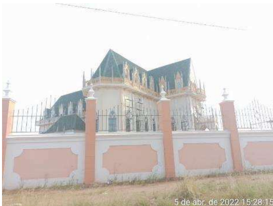
Foto 88 - Igreja católica em construção (Piraquara). Fonte: MRS Estudos Ambientais, 2022.
